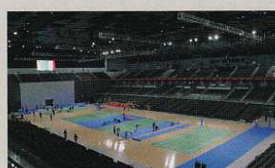
9 ここからは装飾もスタート。コートと床の段差ができないように装飾する
