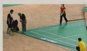
7 床とコートの端をテープで固定。剥がれることがないように貼る
